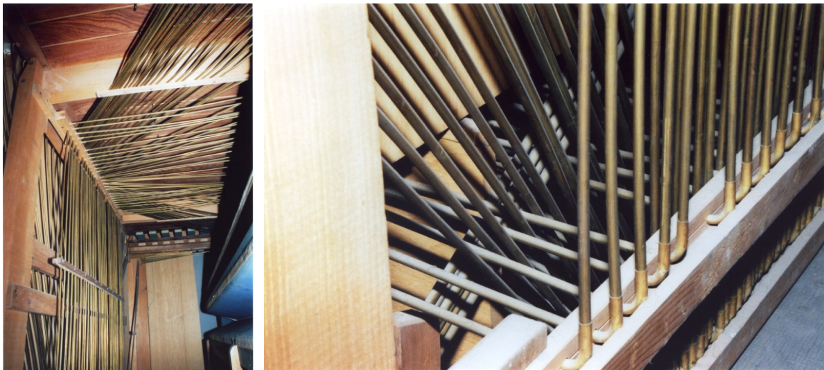
Die noch völlig originale, sehr sorgfältig verlegte Messingröhrentraktur von 1898 – hier in Nendaz ein orgelbaugeschichtliches Denkmal von nationaler Bedeutung!
