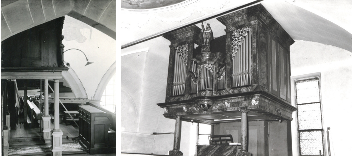
Luzern, Franziskanerkirche, während des Umbaus 1919 (links) und Bauen, Zustand 1920 (beide Fotos: Archiv Firma Goll, Luzern)
