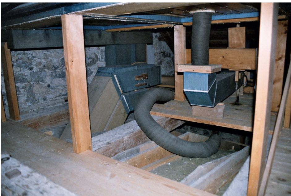
Der frei im Estrich aufgestellte Magazinbalg (Fotos: Bernhard Hörler 2009)
