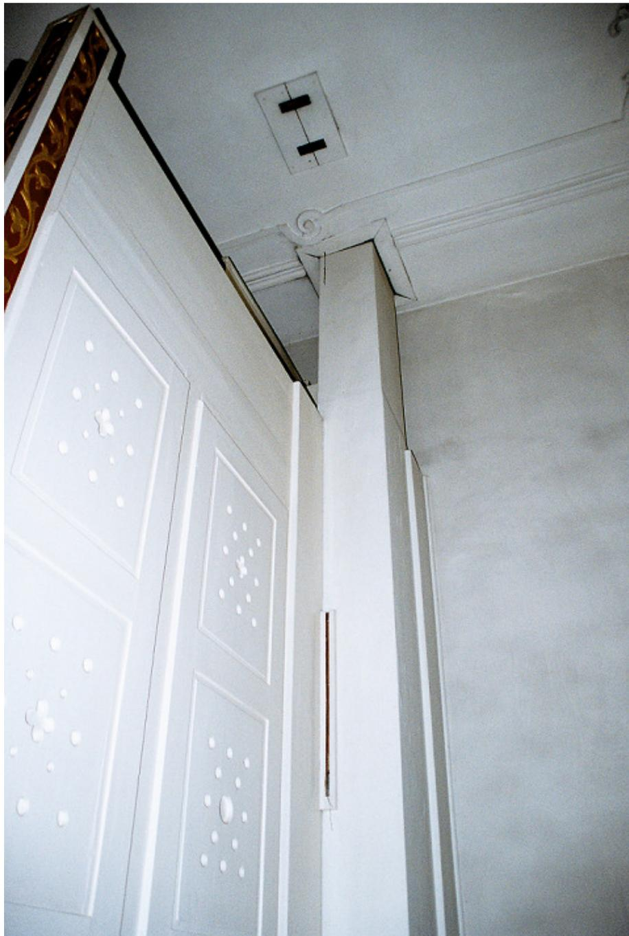
Der Windkanal und die beiden Löcher des Gestänges
